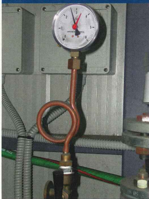
Il manometro di una centrale frigorifera: il tubo di rame viene utilizzato anche in questo caso per le sue particolari prestazioni.
